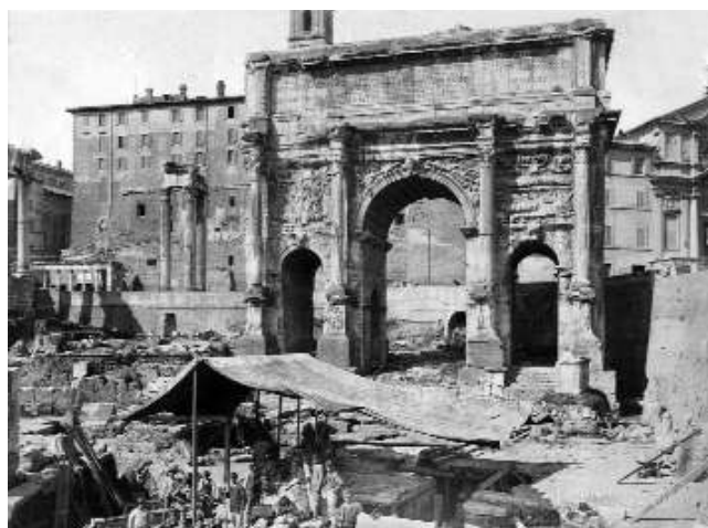
Lavori di liberazione in corso, fine '800
