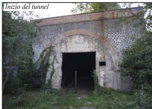
Inizio del tunnel
