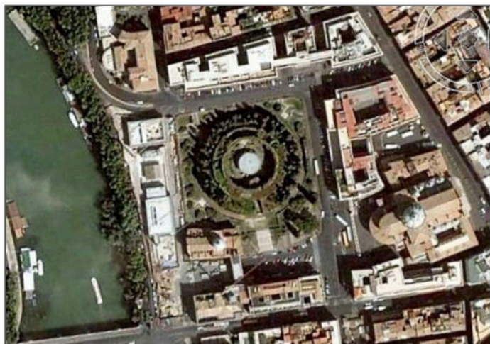
2005: la piazza durante i lavori per la «pompa di benzina»
